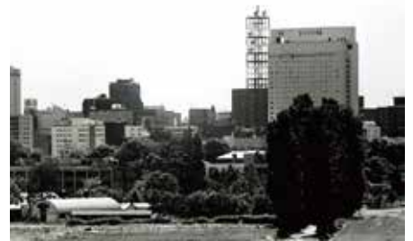
▶建設当時の様子
